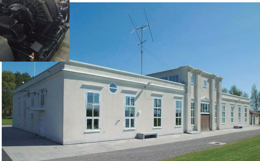
Foto 4: Frente del edificio que aloja la estación SAQ
